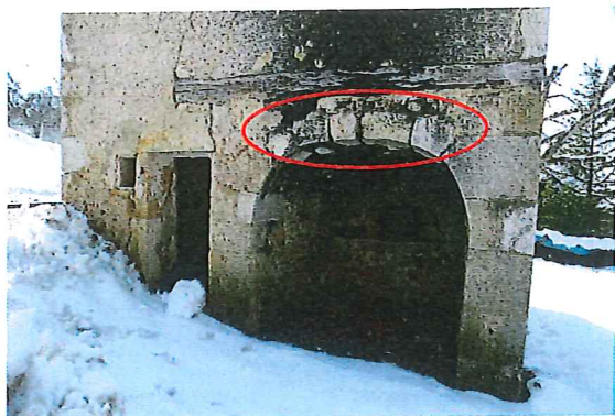
Figure 6 : Four à pain avec tuf calcaire sur la commune de Quintal (Haute-Savoie) © Jérôme Daviet
